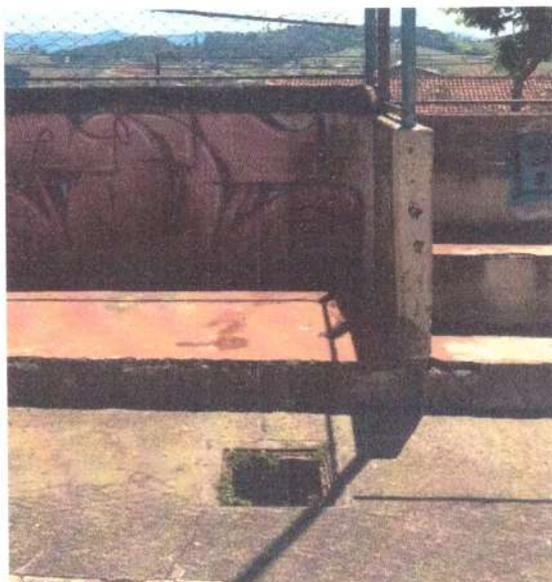
Figura 20 - Caixas pluviais
